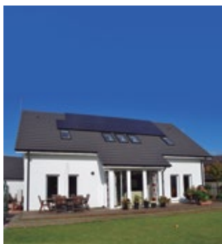
Využijte RHI na maximum. Nemovitost střední velikosti mimo veřejné sítě. Fife, Skotsko. AQUAREA
