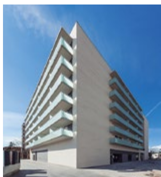
Nová budova s 84 byty v barcelonském Cornella de Llobregat. AQUAREA
