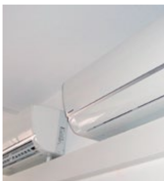
Mnichovská městská nemocnice těží ze zařízení Panasonic PKEA ve své serverovně. RAC
